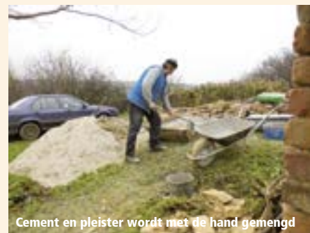
Cement en pleister wordt met de hand gemengd
